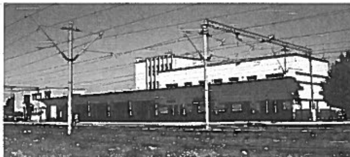
Figură 23. Clădirea gării din Campia Turzii Sursa: autorii studiului
