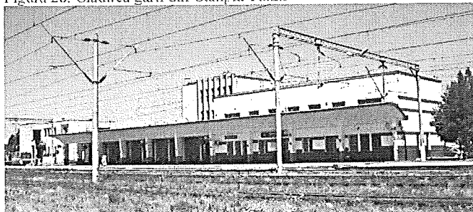
Figură 28. Clădirea gării din Campia Turzii
