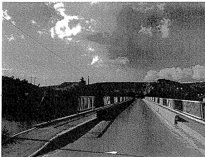
Foto nr. 10 - Pod peste Arieș - Calea Turzii
