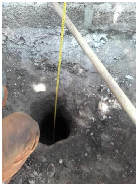
Fig 1 –sondaj deschis la fundatie –S1 / C1- cladire de invatamant
