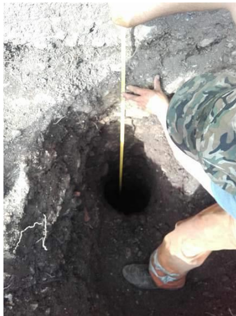
Fig 2 –sondaj deschis la fundatie –S1 / C2 – sala de sport
