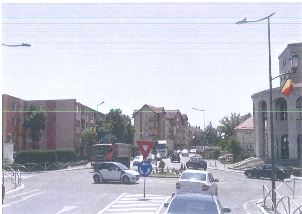
Sens giratoriu cu iluminare neconforma-lampa pietonala montat sus,acest tip de lampa nu se foloseste in iluminatul pietonal stradal.
