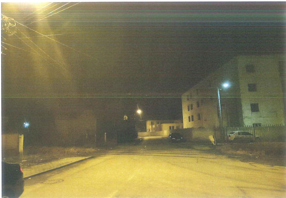
Strada Izvorului iluminat necorespunzator-lampi sodiu interzise din aprilie 2017
