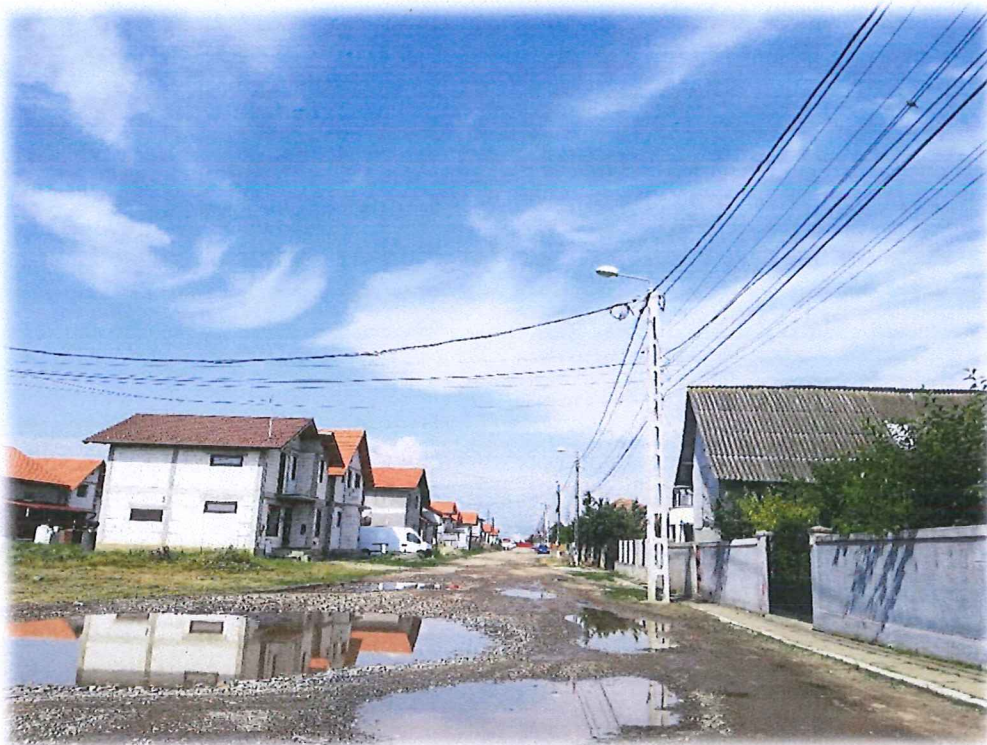
Foto nr. 2 – Situație Existentă – Strada Nicolae Titulescu
